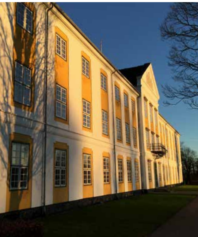
Fig. 6. Augustenborg Slot ved Sønderborg. Tidligere anvendt som sindssygehospital, men skal nu huse cirka halvdelen af NaturErhvervsstyrelsens medarbejdere. Foto: Mette S. Truelsen
