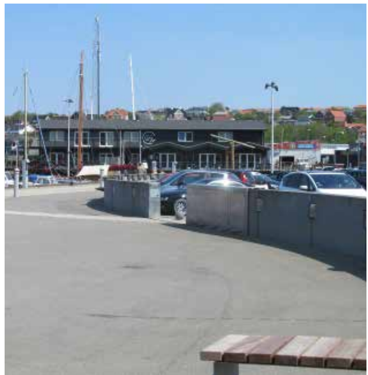
Fig. 2. Det nye højvandsværn i Lemvig Havn 2012. Foto: Henning Lehmann
