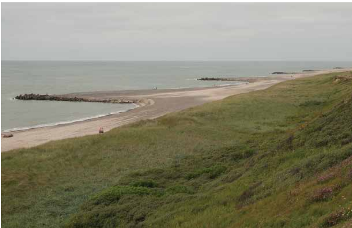
Fig. 8. Kystsikring på den Jyske Vestkyst syd for Bovbjerg Fyr. Høfder ses mange steder langs de danske kyster, og er konstrueret for at afhjælpe erosionsproblemer. På billedet ses det tydeligt at sedimentet aflejres på den nordlige (højre) side af høfden. Dette skyldes, at den langsgående materialetransport på denne kyst er rettet fra nord mod syd (højre mod venstre i billedet), og at sedimentet fanges på opstrøms side af høfden. Foto: Mikkel Fruergaard
