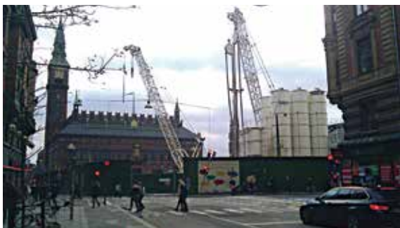
Metrobyggeriet på Rådhuspladsen.
