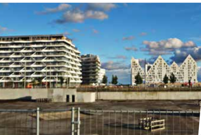
Fig. 3 Kommunen står for byggemodning af arealerne, men pilotering med betonpæle ned i undergrunden bekostes af den enkelte bygherre.
