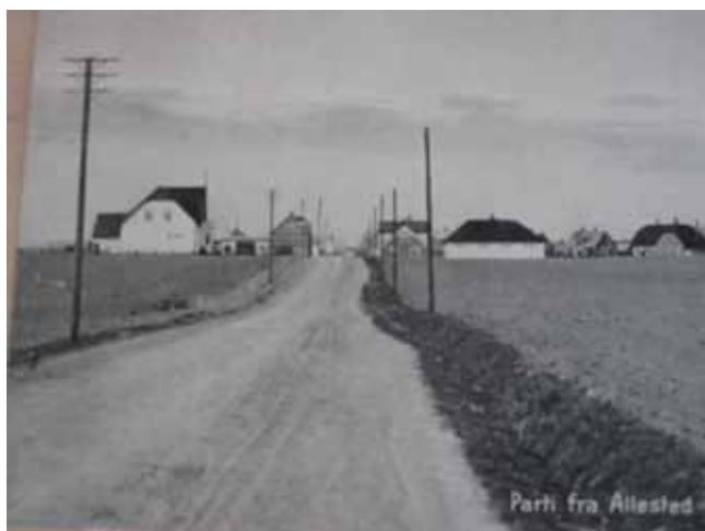
Fig. 9. Udsigt fra Allested mod Vejle. Bemærk stangrækkerne med den nye tids installationer. Det er telefonledninger til venstre, mens elforsyningen forløber til højre. Kilde: Postkort, Niels Ulrik Kampmann Hansen.
