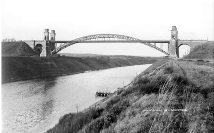
Figur 7. Jernbanehøjbroen ved Grünental i sin oprindelige skikkelse. Broen er bygget 1893-94, og blev i 1988 erstattet af en nybygning i beton. En pendant eksisterer stadig ved Levensau, dog uden tårnene. Kilde: Arkivet ved Dansk Centralbibliotek for Sydslesvig.
