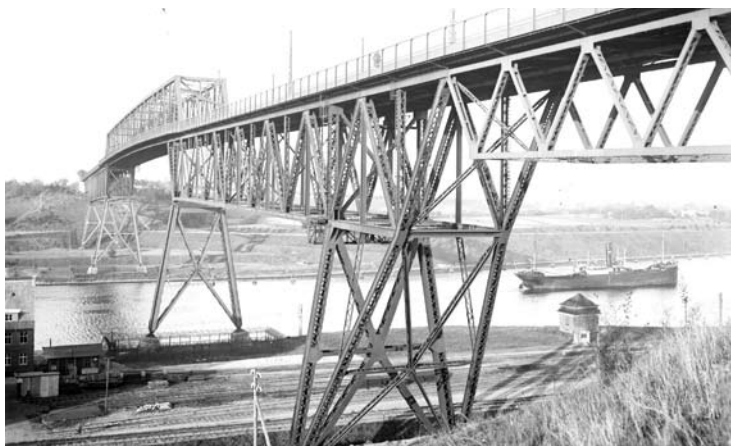
Figur 6. Jernbanehøjbroen ved Holtenau er bygget 1909-12 og blev i 1972 erstattet af moderne betonbroer. Kilde: Arkivet ved Dansk Centralbibliotek for Sydslesvig.
