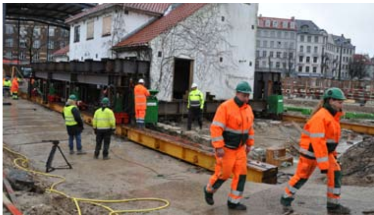
Figur 4. Stationen Nørrebro Runddel bliver placeret i hjørnet af Assistens Kirkegård. Det har længe været planlagt, at denne del af Assistens Kirkegård, skulle omdannes til park fra 2020. Under det forberedende arbejde er den fredede graverbolig blevet midlertidigt flyttet. Når stationsbyggeriet er overstået, vil den blive flyttet tilbage til sin oprindelige placering. Foto: Lene Skytthe, Metroselskabet.
