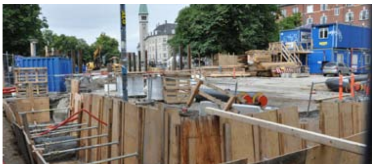
Figur 2. På Enghave Plads er arbejdet i fuld gang med at omlægge ledninger og rør for at gøre plads til, at den kommende metrostation kan bygges her. Under Enghave Plads har det bl.a. været nødvendigt at omlægge Bovederekanalen – en af landets største og ældste kloakrør. Foto: Lene Skytthe, Metroselskabet.
