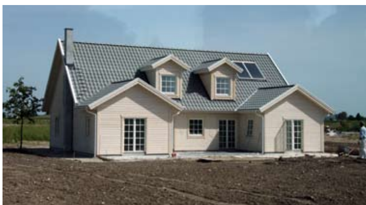
Figur 3. Eksempel på lavenergihus i Stenløse Syd. Foto: Ove Mørck.
