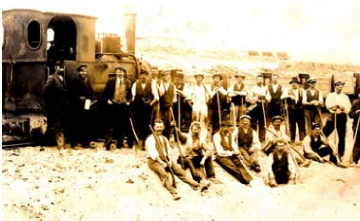
I tre år knoklede 400-500 mand med skovl, trillebør og muskelkraft for at bygge dæmning, indløbskanal og kraftværk. Her ses et arbejdsjak på den kommende dæmning. Foto: Elmuseet.
