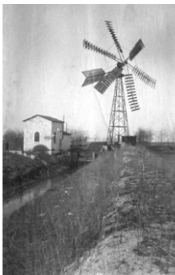
En vindmotor (6-vinger klapsejler) ved en af Rødby Fjords mange forgreninger. Som hjælpemotor ved vindstille er der bygget et pumpehus til en petroleumsmotor. Pumpeværkerne blev overflodiggjort i 1927, da en ny stor diesel pumpestation stod færdig til fælles tørlægning af hele Rødby Fjordkomplekset. Foto: H. M. Markersen ca. 1925.
