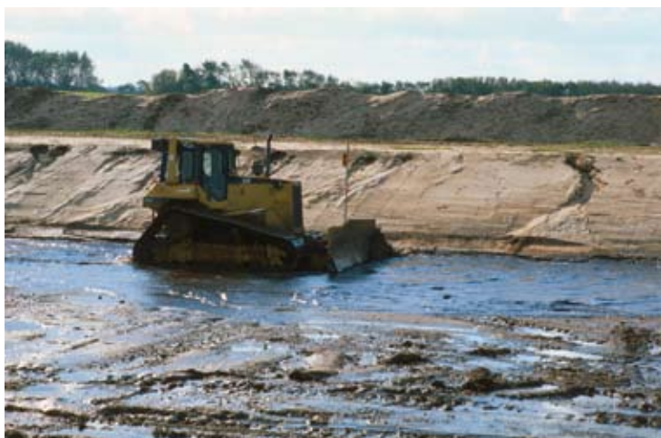
Udgravningen af den reetablerede Skjern Å, hvor der i alt er flyttet 2,7 mio. m 3 jord, svarende til en ubrudt række af dumpere med jord, der strækker sig fra Skjern til Rom. Foto: Skov- og Naturstyrelsen.
