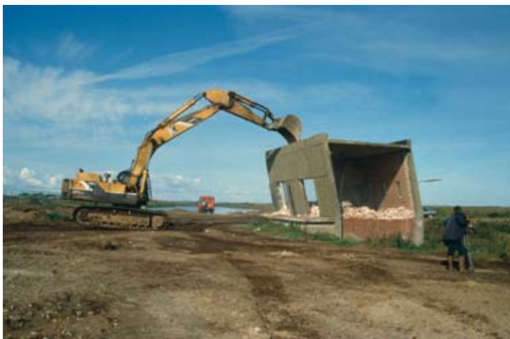
Nedrivning af en af de pumpestationer, der tidligere pumpede vand væk fra området, men i forbindelse med naturprojektet er blevet overflødig. Foto: Skov- og Naturstyrelsen.
