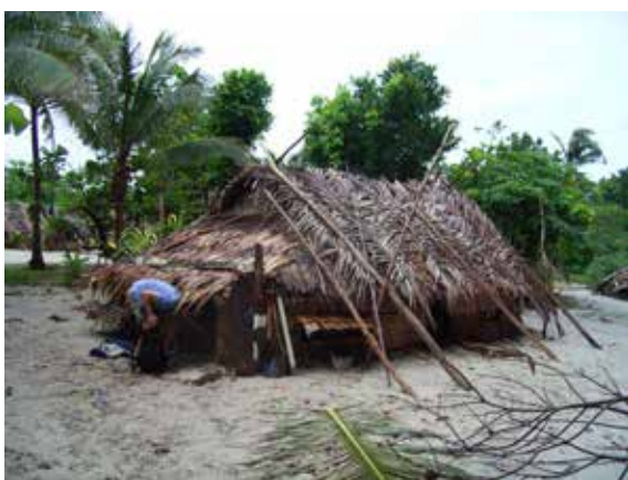
Fig. 6. Et typisk hus på Tikopia. Bemærk den lave højde på huset som en form for cyklonsikring. Man bliver nødt til at kravle ind. Foto: Thilde Bech Bruun
