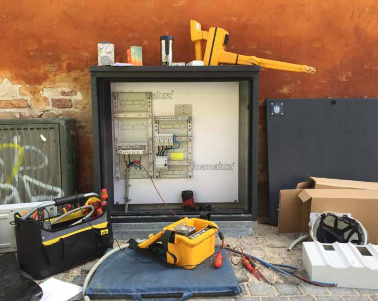
Fig. 1. Gadeskab med fiberfremføring, som skal fordeles ud til de kablede wifi access points, som skaber netværk i området. Foto: Rikke Gram-Hansen
