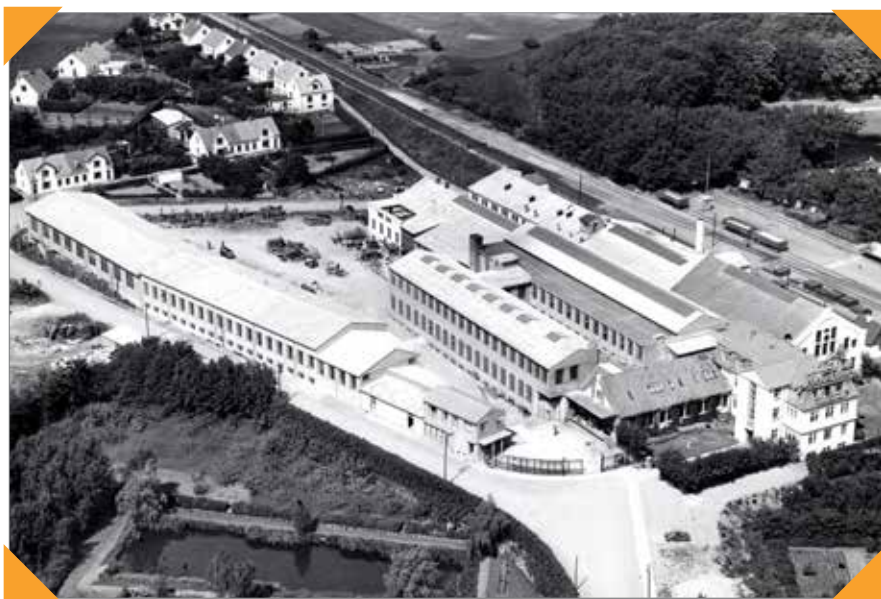
Fig. 4. Peder Nielsens slagfabrik, 1940. Jernbanen til Brønderslev åbnede i 1871 og i 1886 etablerede fabrikken, der skulle blive en drivkraft i byen, sig ved stationen, og var i mange år afhængig af jernbaneforbindelsen til kunderne. Købstædernes eneret på handel blev ophævet ved lov, der trådte i kraft 1862, og eksport af forarbejdede landbrugsprodukter accelererede. Sidste halvdel af 1800-tallet omfattede en voldsom fornyelse og berigelse af samfundet. Danmark blev industrialiseret, og industrien med dens krav til store arbejdsstyrker blev koncentreret i byerne. Jernbanerne åbnede indlandet, og konsekvensen blev en voldsom vækst af handels- og industribyer med lokal forankring. De nye byer – ofte kaldet stationsbyer – fik især succes på steder, hvor der var langt til de gamle købstæder. Foto: Lokalhistorisk Arkiv, Brønderslev.
