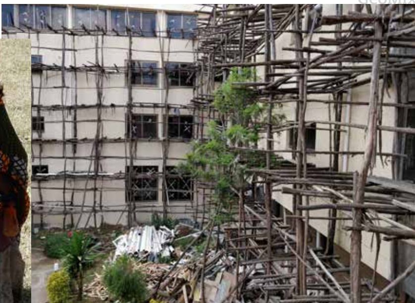
Fig. 4. Stillads af rafter. Selv bygninger i mange etager havde stilladser af træ. Hvad mon en dansk arbejdstilsynsmand havde sagt til det?
