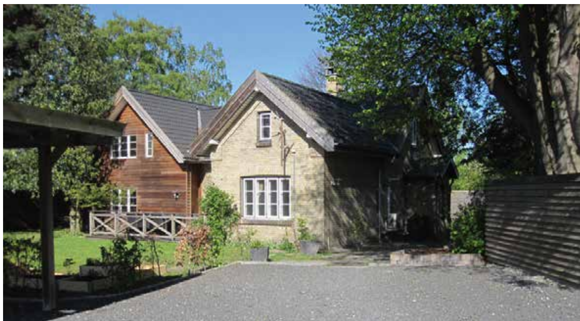
Fig. 5. Nutidigt foto af ledvogterhus på Nordbanen. Frem til 1935 krydsede Ørnegårdsvej Nordbanen i niveau, herefter blev der bygget Danmarks første motorvejsbro (i 1935) og ledvogterhuset var tjenestebolig for en DSB-ansat. Omkring år 2000 blev huset istandsat og fik en ny fløj. (Foto: NUKH.)
