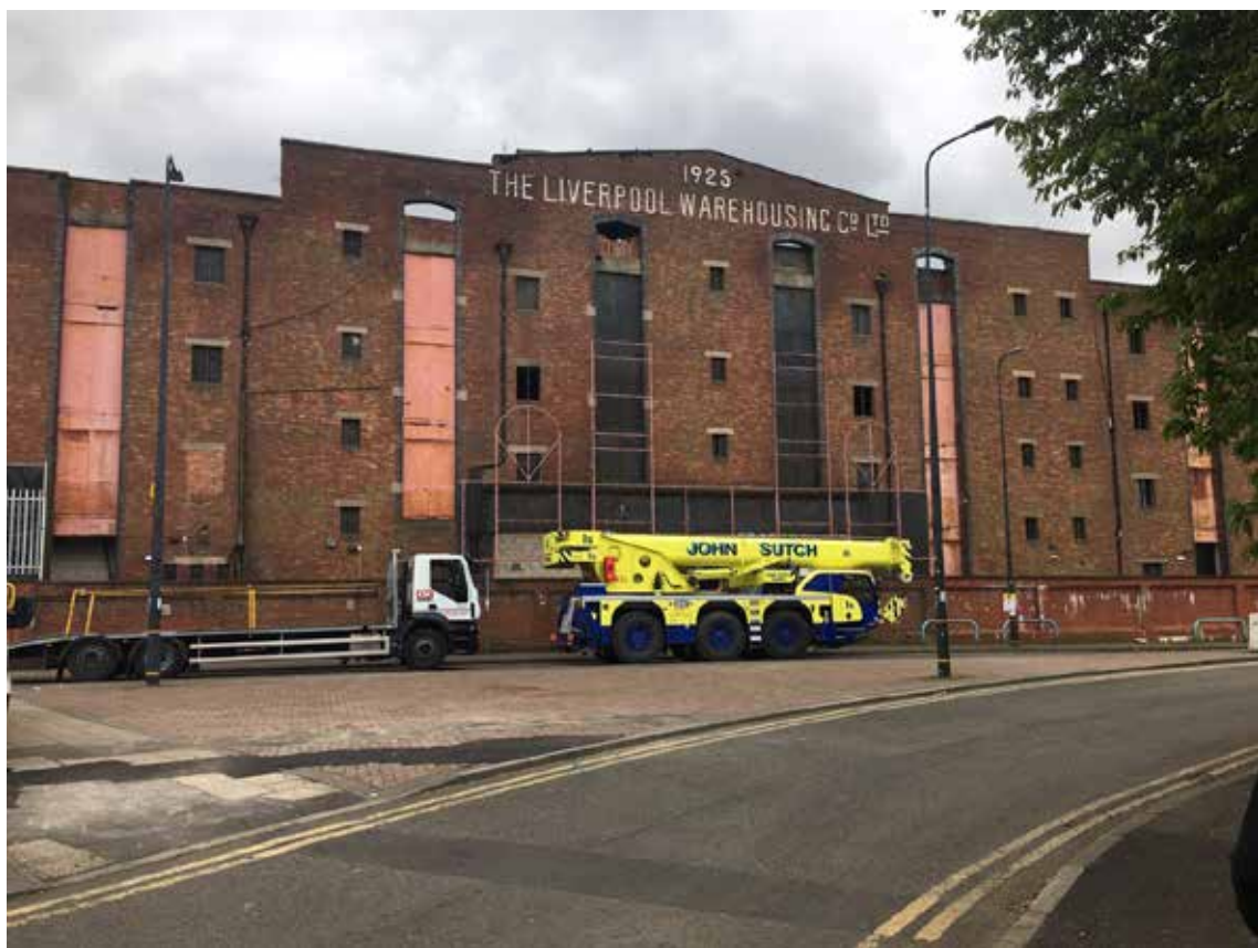
Forladt erhvervsbyggeri i Manchester. Foto: Lars Winther
