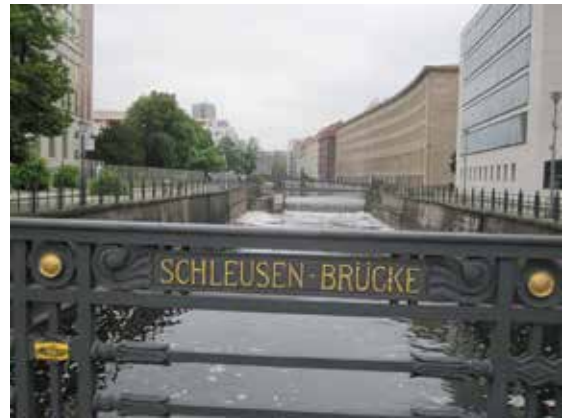
Fig. 12. Berlins ældste bevarede bro: Jungfernbrücke fra 1798. Broen kunne oprindeligt hæves, men kædetrækket er ude af drift, og trafikken ledes nu udelukkende ad den østlige Spree-arm. Den vestlige arm kaldes Schleusengraben. Foto: NUKH 2013.
