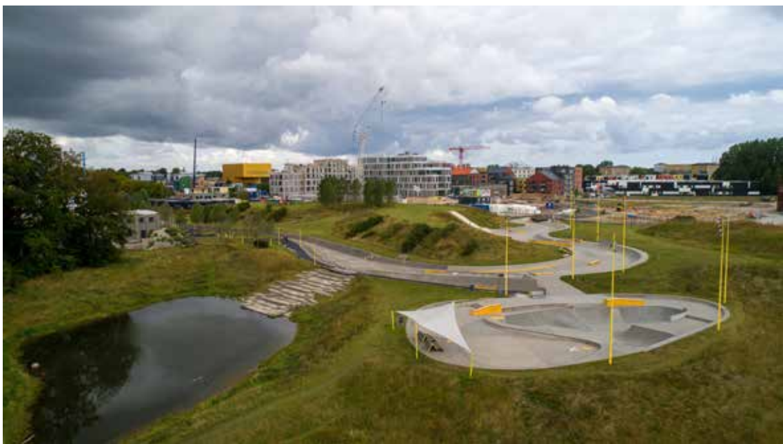
Rabalderparken set fra sydøst med regnvandskanal, sø og skatebowl. Engområdet, som udgør tredje del af det samlede regnvandsbassin, ligger uden for bunden af billedet. Foto: INSP! Media
