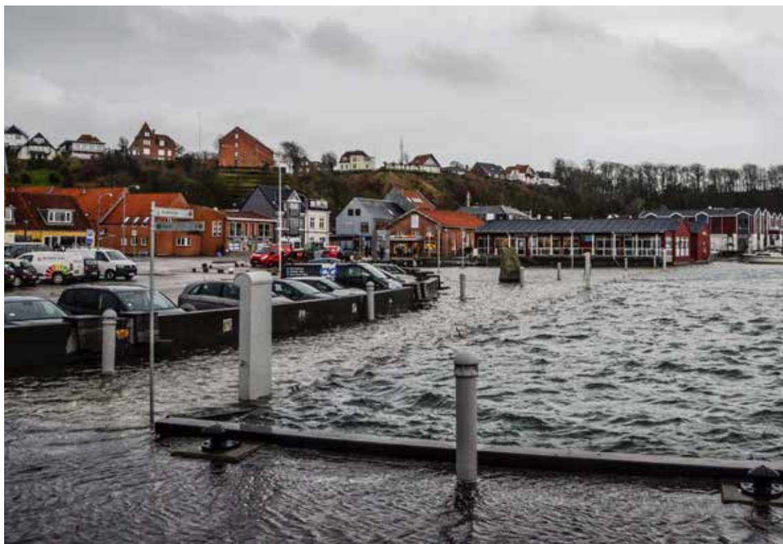
Eksempel på kystbeskyttelse der skaber nye byrum: Højvandsmuren i Lemvig. Øverst: Muren er lukket og beskytter mod højvande i februar 2020.
