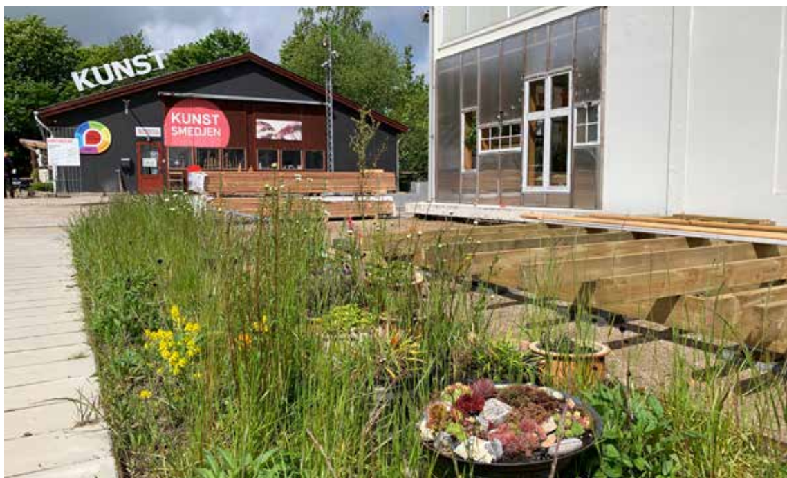
Alle steder i Musicon-bydelen er vandet og dets betydning synligt. Her i et regnvandsbed, som forsinker nedsvivningen. Ved store mængder vand løber den overskydende del ud i hovedgaden, Rabalderstræde, og videre til regnvandsanlægget i Rabalderparken. Foto: Kasper Brøndum Andersen
