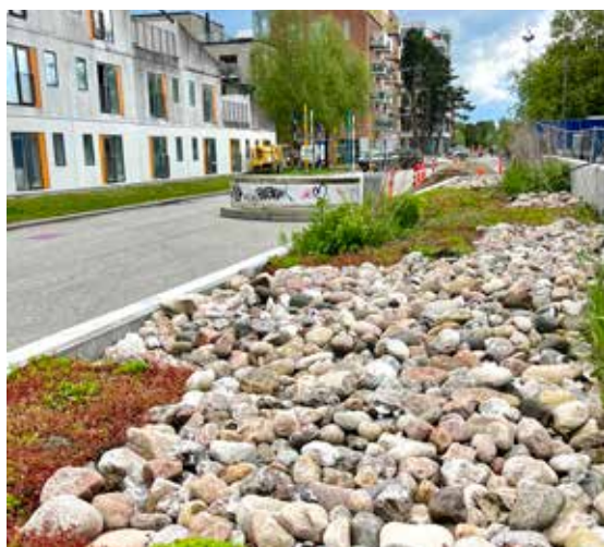
En måde at synliggøre vandets kredsløb er det hævede regnvandsbed og sandfilter i den nordlige ende af bydelen et eksempel på. En pumpe sender vand fra regnvandssøen i Rabalderparken i bydelens modsatte ende op til regnvandsbedet, hvorfra det pibler langs vejen tilbage til søen. Foto: Kasper Brøndum Andersen
