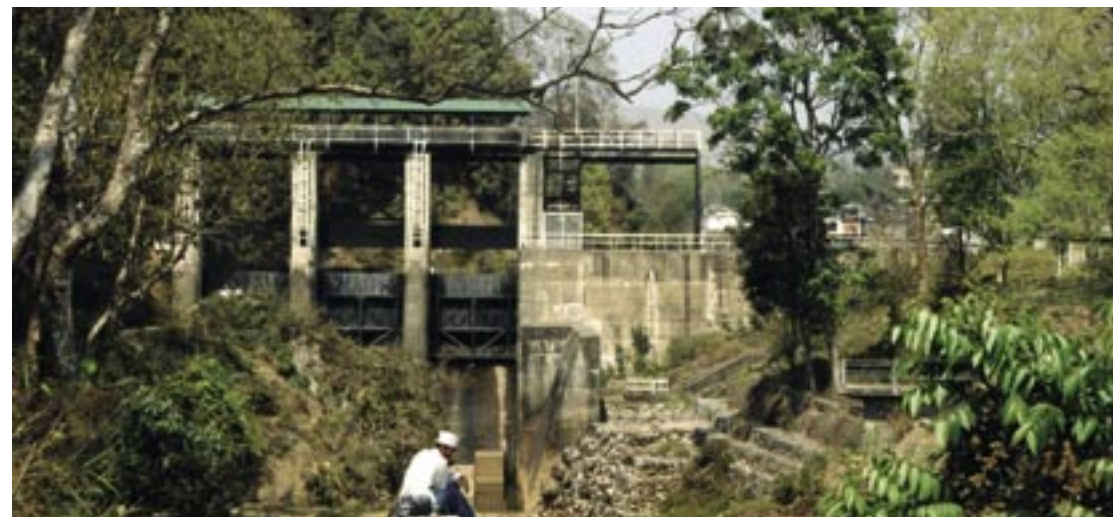
Phewa på 1 MW, Et mellemstort "small-hydropower" vandkraftværk i Nepals næststørste by Pokhara, der forsyner en stor del af byen med strøm.
