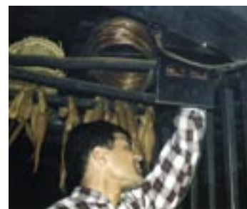
For at de små vandkraftværker kan klare presset fra de mange husholdninger, der er tilsluttet, installeres sikringer i husene, der brænder over, hvis der bliver trukket for kraftig på dem. Her er en elektriker fra den nærmeste store by Pokhara ved at installere en sikringsgruppe til et fjernsyn.
